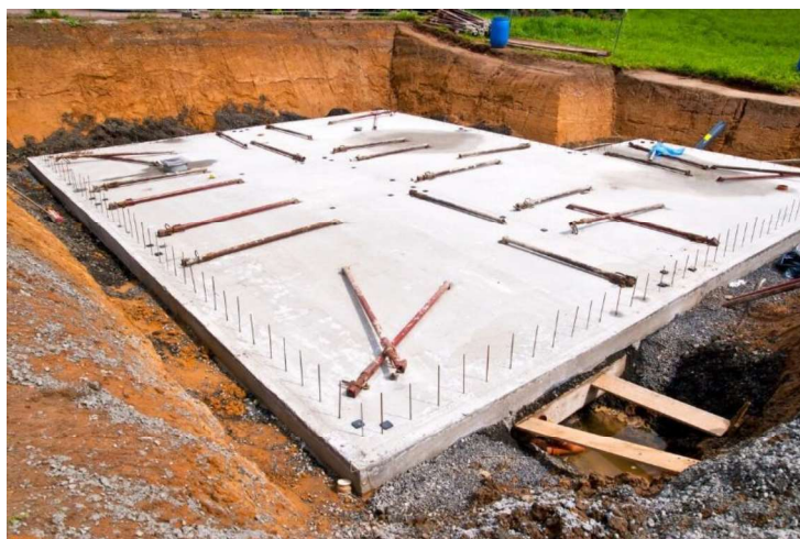
Figura 31: Exemplo de Fundação Radier.
