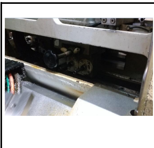
Figura 23 - Antes – Realização do aperto com chave allen e prolongador.
