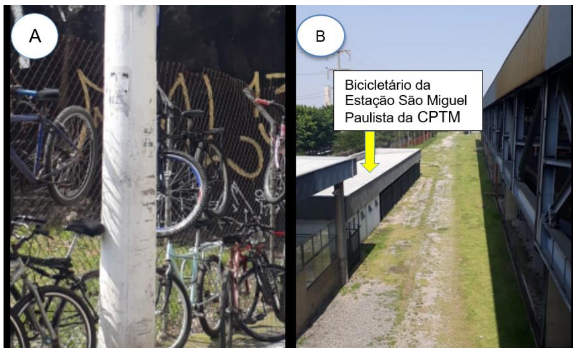
Figura 2- Situação em frente ao bicicletário da Estação São Miguel Paulista da CPTM
