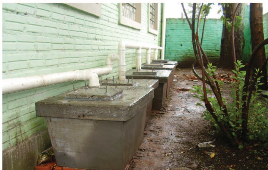
Figura 16. Amostrador que coleta água da chuva do telhado, segundo Hagemann (2009)
