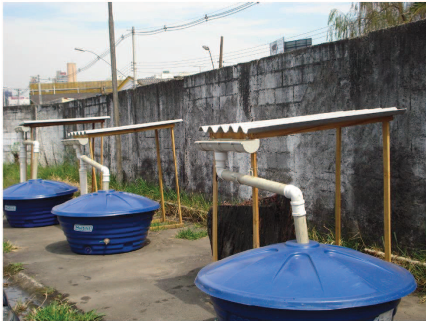
Figura 17. Dispositivos para coletar água de chuva com zero, 2mm e 5mm de descarte do escoamento inicial, de acordo com Santos (2010)
