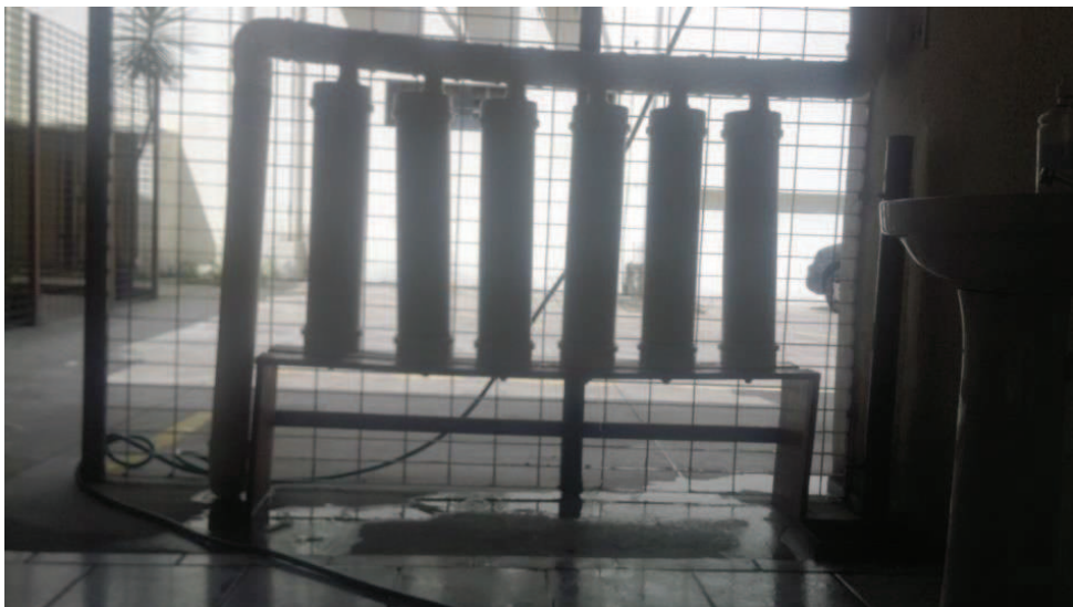
Figura 39. Banco suporte envergando com o peso da água nos reservatórios
