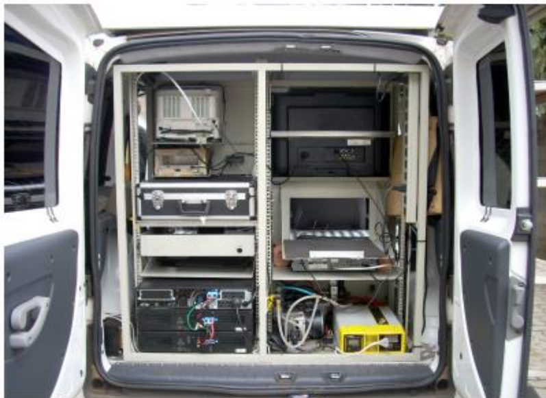
Figura 24 - Traseira do veículo com monitores e equipamentos de transmissão
