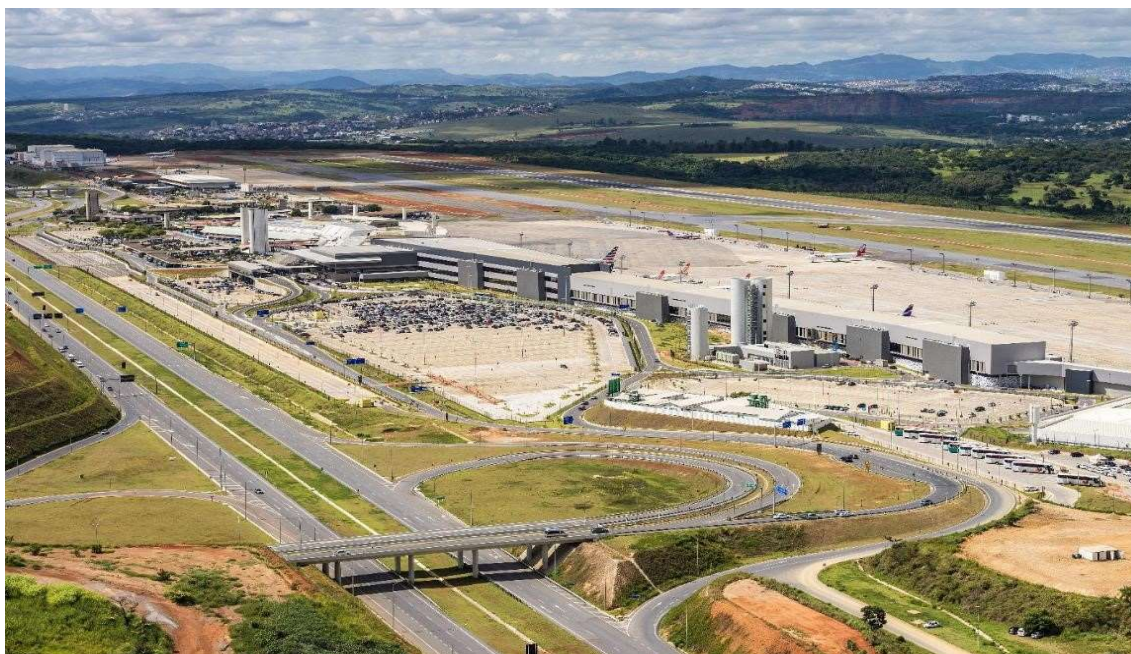
Figura 15 – Aeroporto de Confins Terminais de passageiros e de cargas
