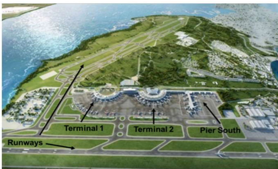
Figura 14 – Vista do aeroporto de Internacional do Rio de Janeiro
