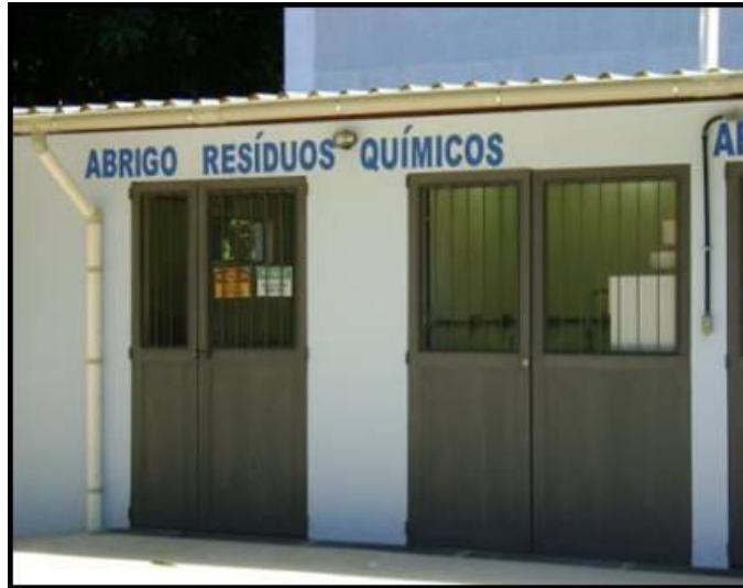
Figura 17 – Abrigo de resíduos químicos do Pavilhão Reitor Haroldo Lisboa da Cunha – UERJ.
