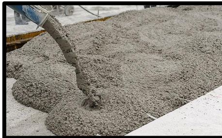
Figura 2: Concreto bombeado
