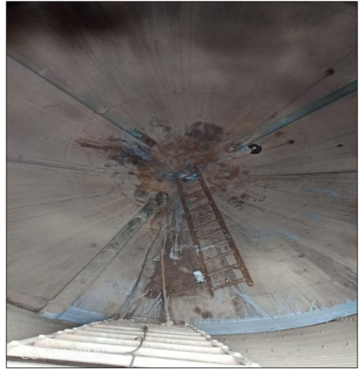
Figura 2: Espaço confinado-manutenção interna
