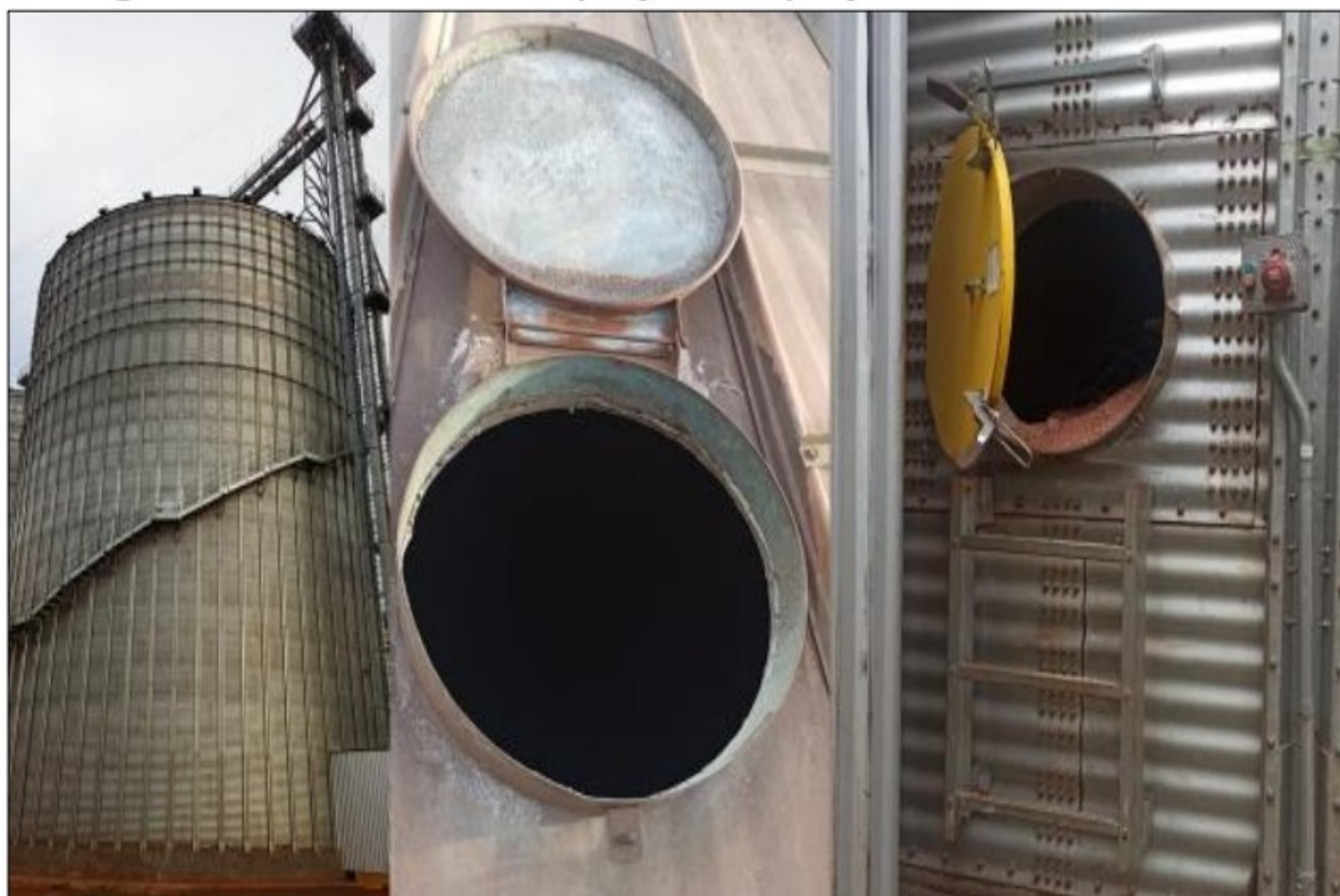
Figura 1: Boca de inspeção-espço confinado-silos
