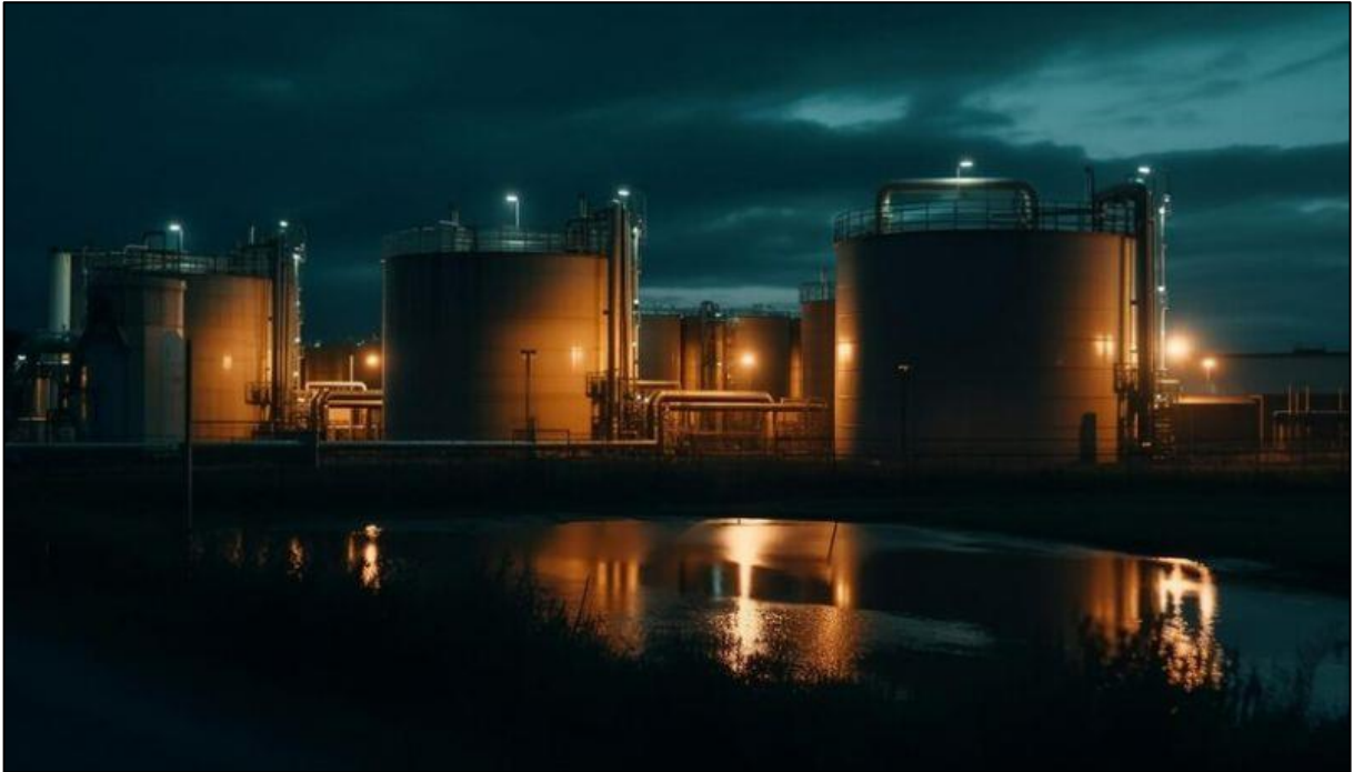
Figura 6- Tanques de etanol
