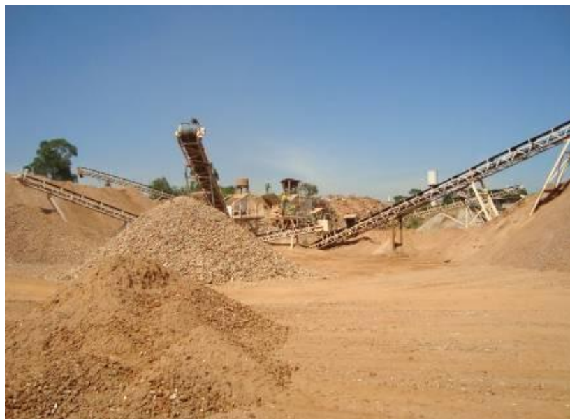
Figura 6 - Vista do Patio de Reciclagem onde se encontra os equipamentos e áreas de armazenagem de resíduos e produtos. (16 /06/ 2010.)
