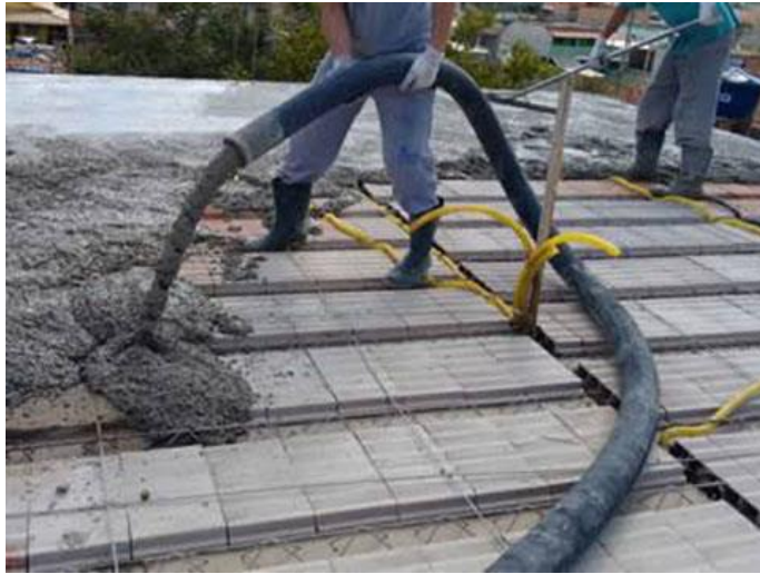
Figura 26 - Concretagem de laje EPS
