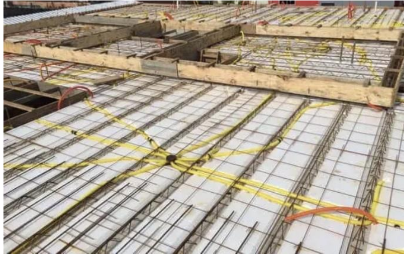
Figura 25 - Conduites para instalação elétrica em laje EPS
