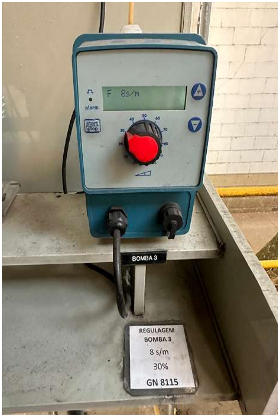
Figura 4.4 - Regulagem da Bomba de Dosagem Tekba - Seko 3 (08 s/m pulso)
