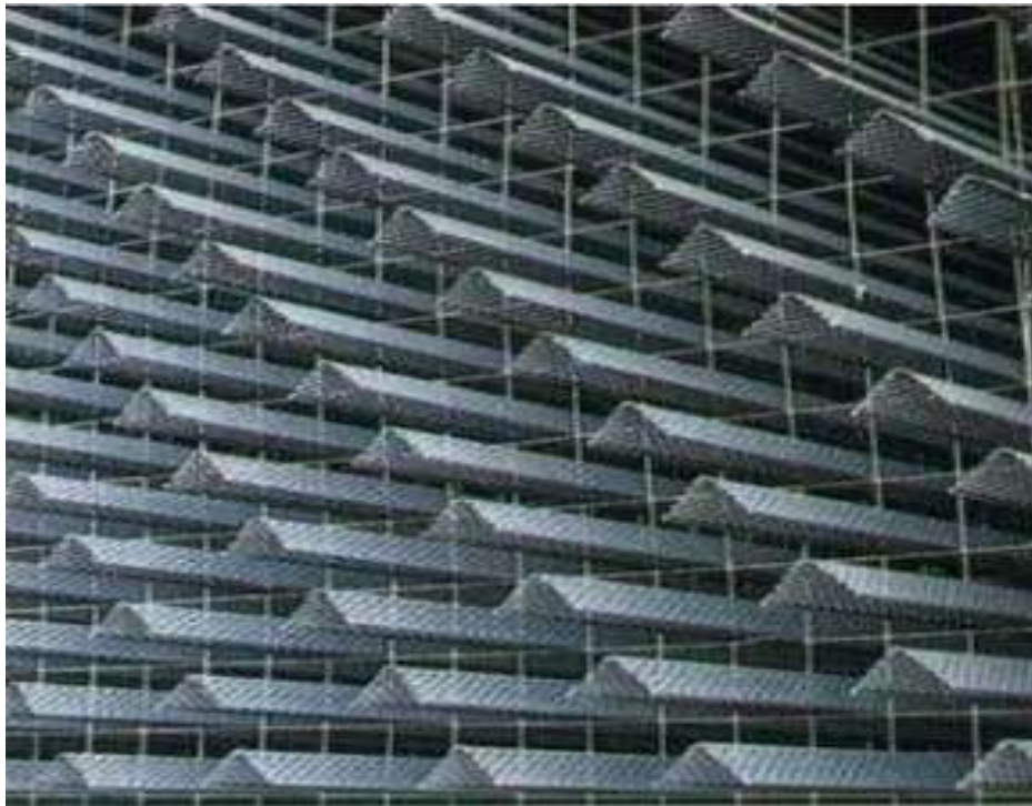
Figura 3.8 - Enchimento Tipo Respingo
