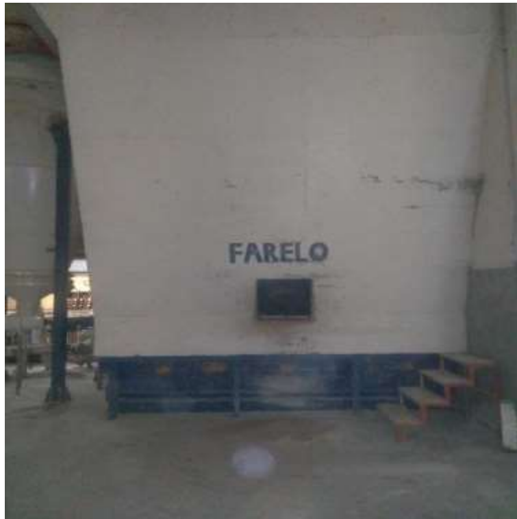
Figura 12 - Silo de armazenamento de farelo
