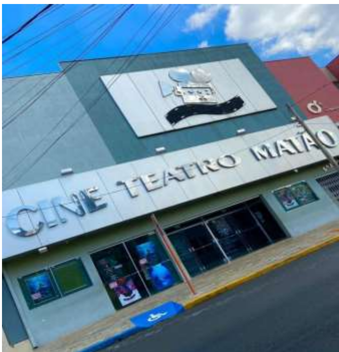
Fotografia 1: Fachada do Cine Teatro Matão
