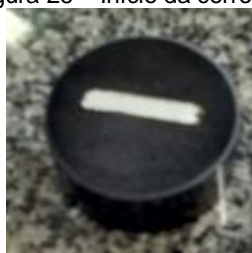
Figura 26 – Início da corrosão
