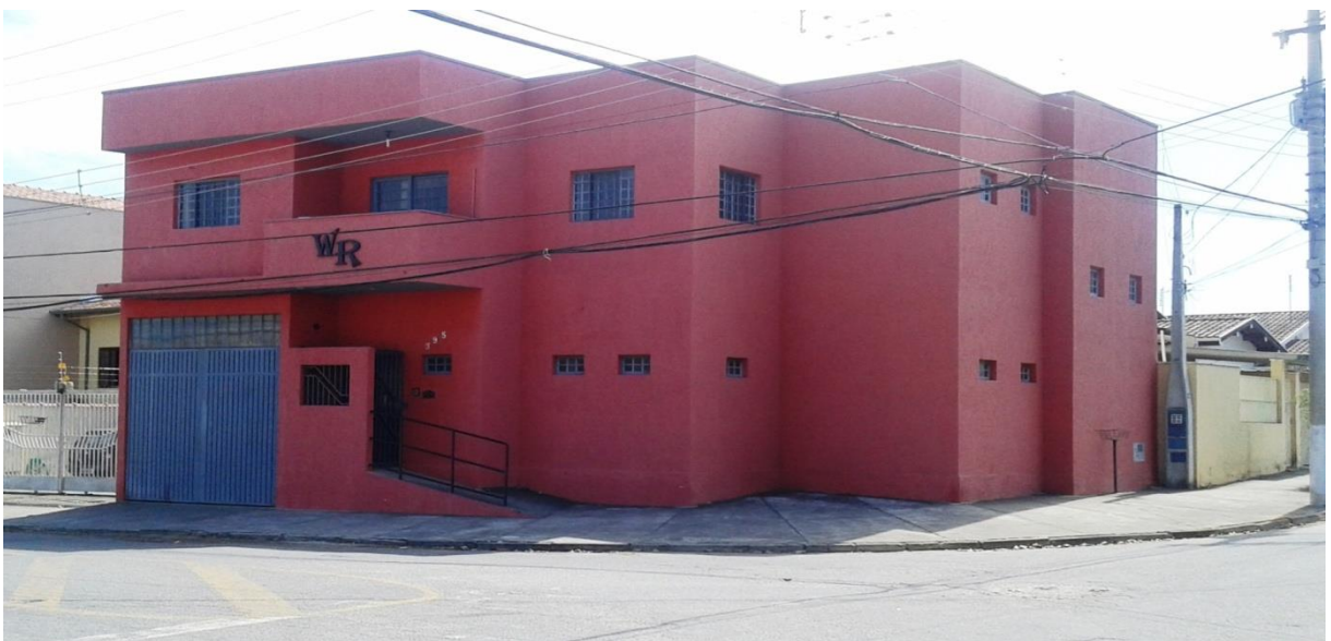
Figura 1 - Prédio da empresa WR Comercio e Manutenção de Eletroeletrônicos.
