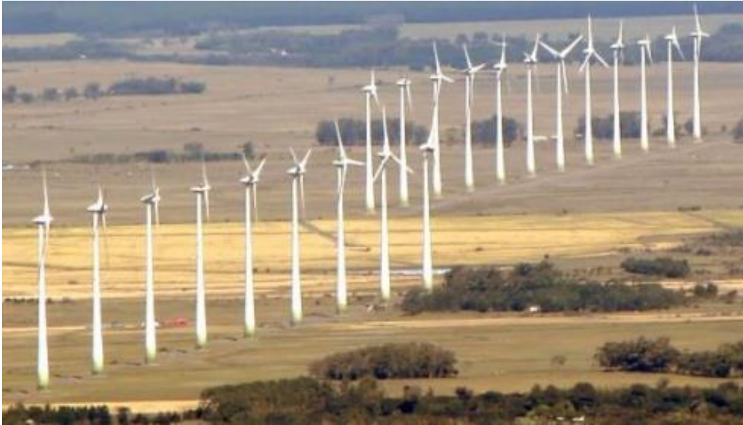
Figura 6 - Complexo eólico de Osório-RS
