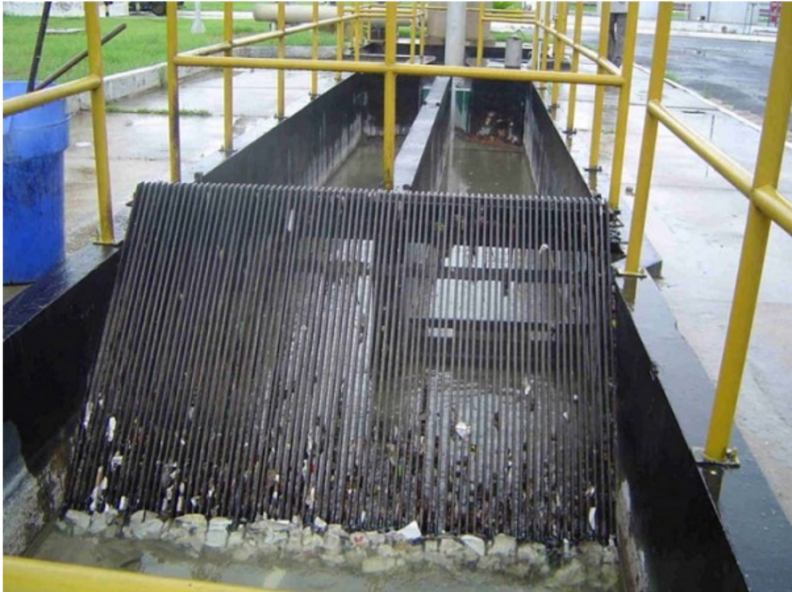
Etapa de Gradeamento. / Foto: Departamento de Engenharia Hidráulica e Ambiental – DEHA/UFC
