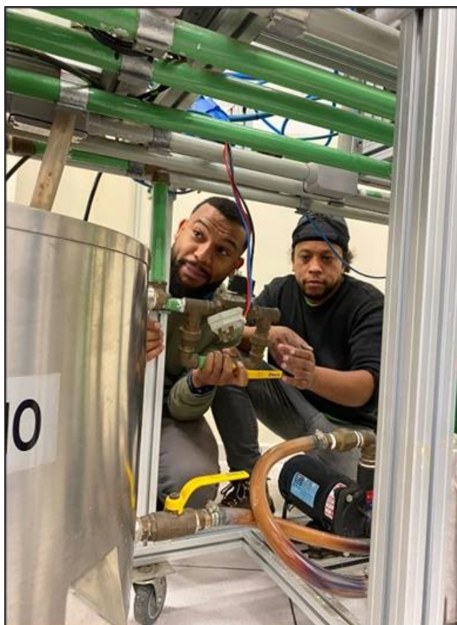
Figura 3.1 – Realizando a troca de tubulações
