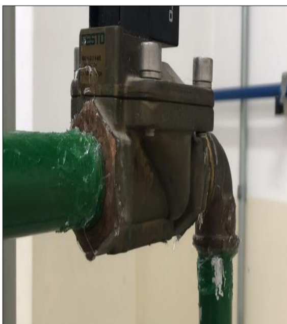
Figura 3.4 – Conexões vedadas com silicone
