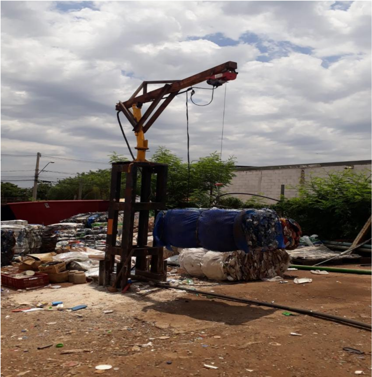
Fonte: Autores do TCC Fotografia: Guindaste içando resíduos (2023)
