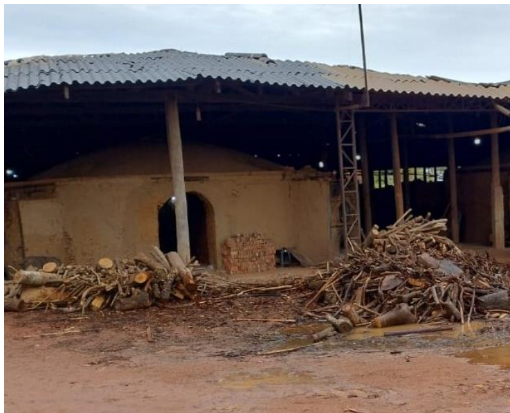
Figura 6 - Local de descarregamento
