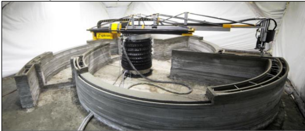
Figura 1.4 – Construção de uma casa por uma impressora 3D
