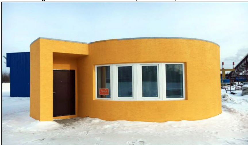
Figura 1.5 – Casa construída por uma impressora 3D
