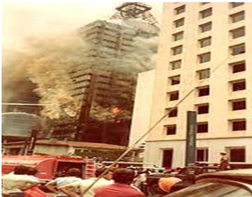
Figura 2 - Incêndio no edifício Grande Avenida 1981
