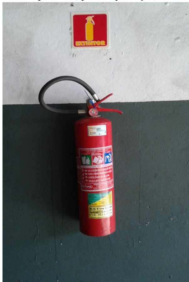
Figura 17. Instalação do extintor de incêndio tipo ABC (após a implantação).
