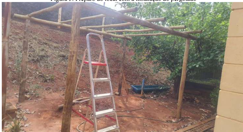
Figura 5: Preparo do local com a instalação do pergolado
