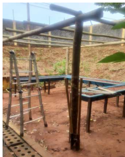
Figura 4: Preparo do local com a instalação das estacas de eucaliptos (a), Instalação da tela do pergolado (b)
