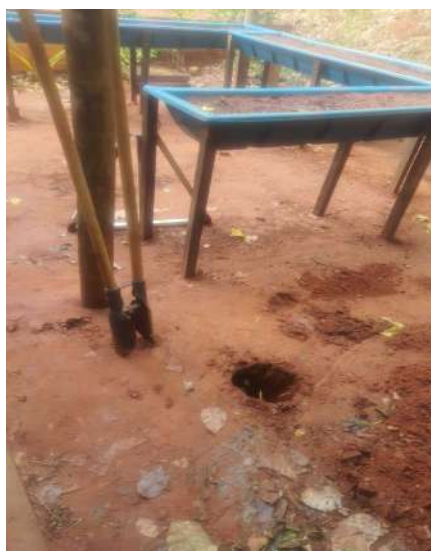
Figura 4: Preparo do local com a instalação das estacas de eucaliptos (a), Instalação da tela do pergolado (b)
