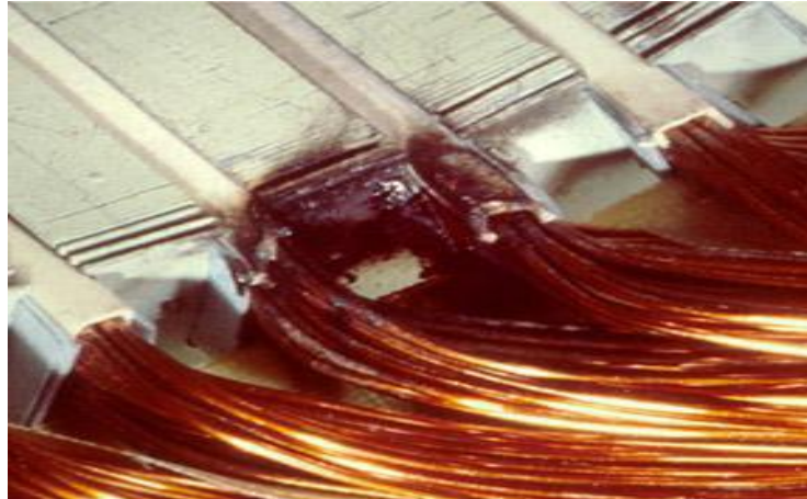
Figura 11- Bobina em curto para massa na saída da ranhura
