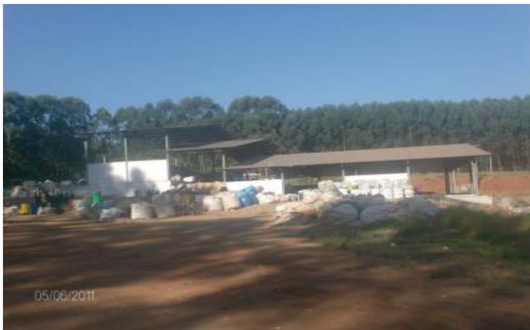
Figura 8 - Barracão da a atual cooperativa junto ao aterro sanitário
