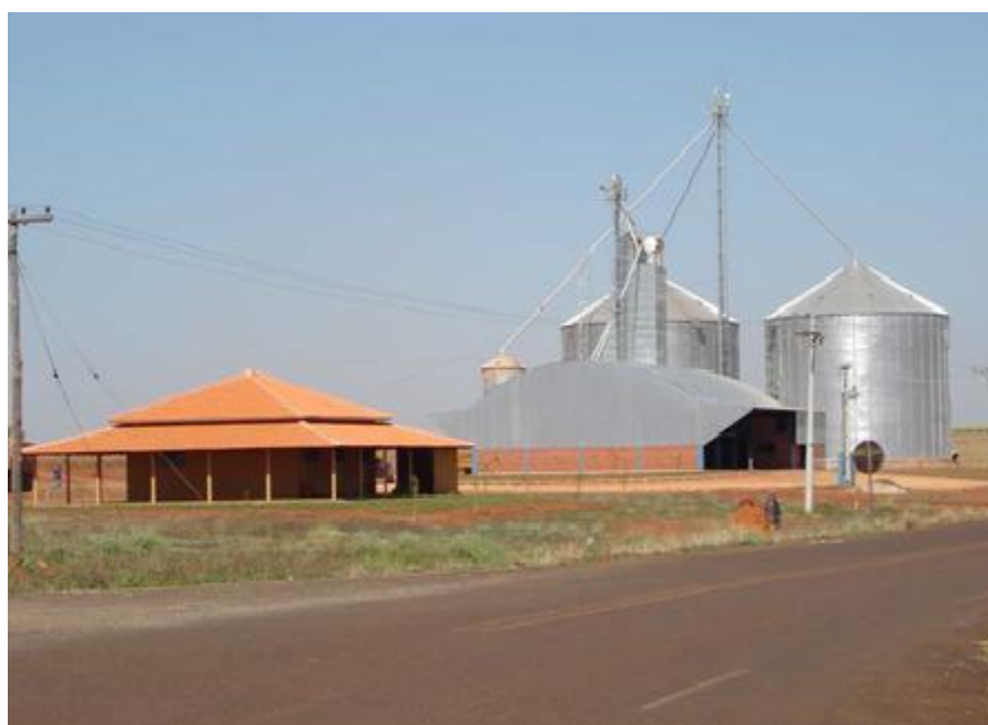
Figura 3- Silo Graneleiro da Coopermota (Campos Novos Pta) Fonte: Coopermota, 2011.
