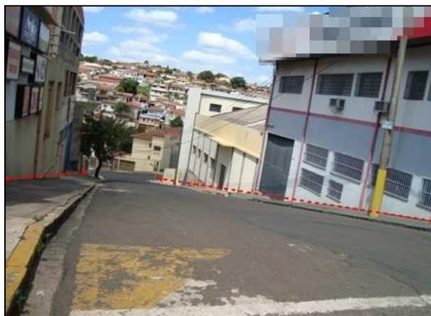
Figura 6 - Calçada com desnível acentuado.
