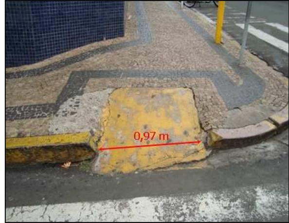
Nas Figuras 48 e 49, observa-se erros comuns nas execuções de rebaixamento de calçada. Saliências no término do rebaixamento, falta de manutenção da via e irregularidades no piso são condições inaceitáveis que prejudicam a acessibilidade.
