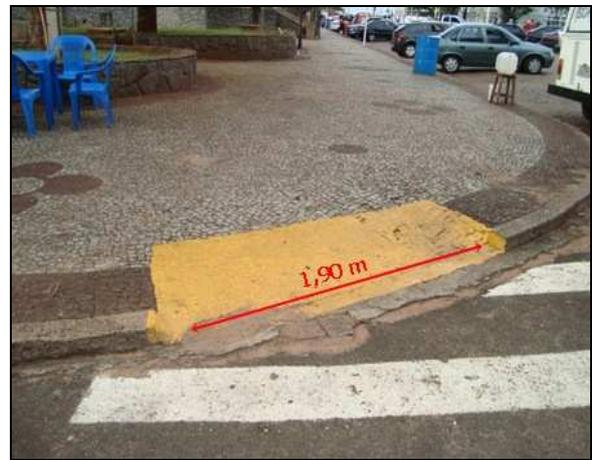
Figura 50 - exemplo de rebaixamento de calçada nas esquinas.
