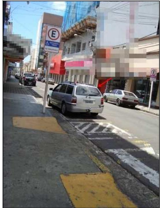
Faixa elevada para travessia de pedestres sem a grelha de drenagem, rebaixamento de calçada fora das normas e bem em frente à tampa com saliências, além da falta de manutenção do piso da calçada, são muitos os motivos encontrados que dificultam a acessibilidade num mesmo espaço, conforme a Figura 80.
