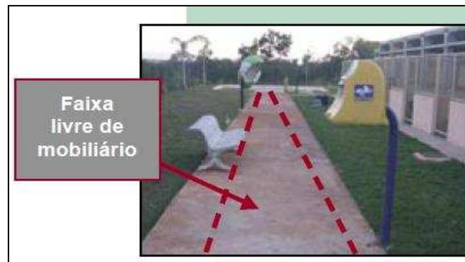
A área mínima de passeio deve ser de 1,20m, conforme Figura 8, ideal para o deslocamento de um pedestre e uma cadeira de rodas com o usuário, embora se recomende 1,50m (Figura 9) para o deslocamento de duas pessoas em cadeira de rodas.
