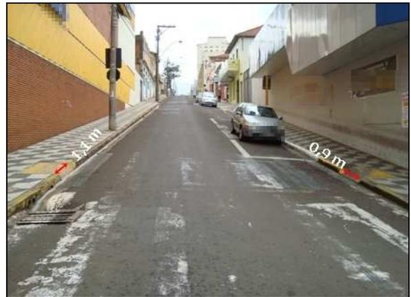
Nas Figuras 40, 41, 42 e 43, observa-se que os rebaixamentos de calçadas não foram projetados adequadamente, pois, além dos pisos serem inadequados e irregulares, há desnível entre o término do rebaixamento da calçada e o leito carroçável que dificulta o acesso e, ainda, faixa de livre acesso fora das medidas adequadas.
