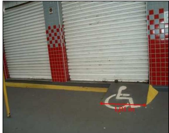
A fachada do prédio privado, conforme a Figura demonstra que há falta de acessibilidade por possuir a entrada principal apenas por escadas e sem corrimão adequado. Verificou-se, também, que o acesso lateral possui uma falsa sensação de acessibilidade, pois a rampa instalada junto à porta foi projetada com imprevisto perigoso, pois o material é inadequado e não fixo.
