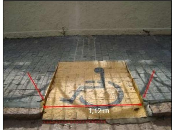
Figura 44, demonstra várias irregularidades na execução do projeto, tais como falta de manutenção e irregularidades no piso, além das dimensões fora das normas estabelecidas pela NBR – 9050.
