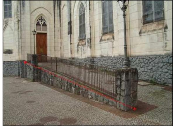
Nas Figuras 29 e 30, observa-se que, apesar da agência bancária oferecer uma vaga reservada para PCDs, a rampa para a entrada do prédio fica na lateral, porém a via possui uma inclinação acentuada, exigindo grande esforço físico de uma pessoa usuária de cadeira de rodas para vencer o percurso.
