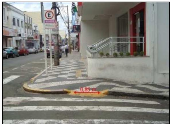
Figura 38, desnível entre o término do rebaixamento da calçada e o leito carroçável, medidas fora dos padrões estabelecido pelas normas e piso irregular.
