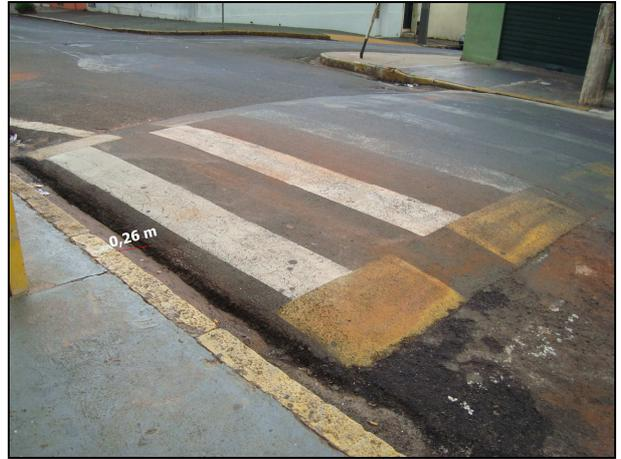
Na Figura 56, tem-se exemplo de faixa elevada com semáforo para pedestres, porém falta da grelha de drenagem e sinalização no piso.
