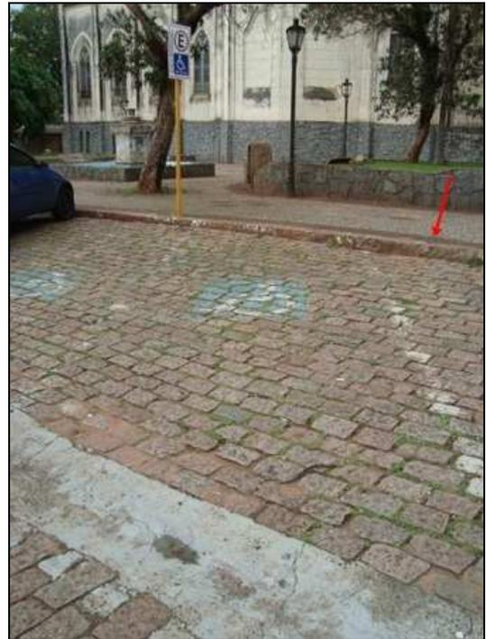
Também fora das configurações, a Figura 66 demonstra que a vaga, além de estar projetada em uma superfície inadequada, a irregularidade está no rebaixamento da calçada, pois está muito distante, dificultando muito a utilização e o acesso da via.
