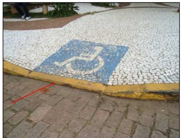
Figura 42 - Desnível no final do rebaixamento.
