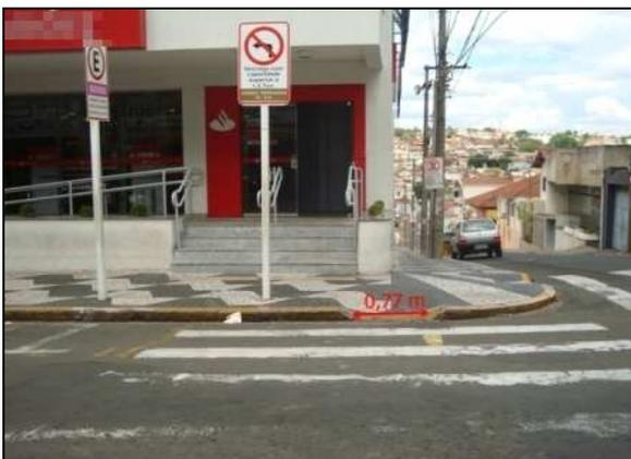
Figura 37 - Rebaixamento de calçada fora de padrão.
