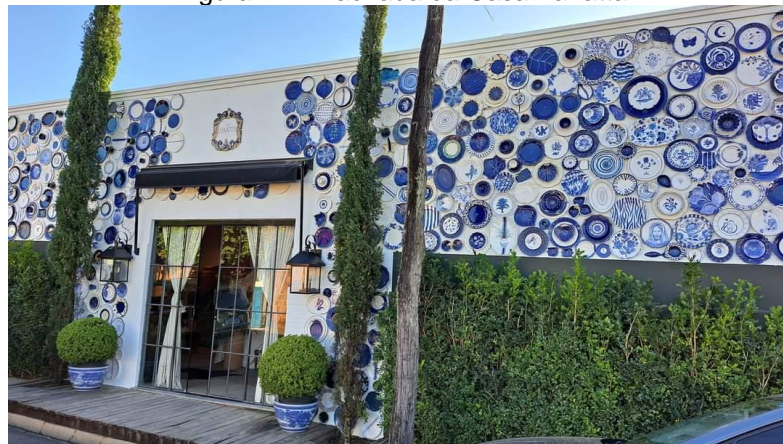
Figura 42 – Fachada da Casa Zanatta
