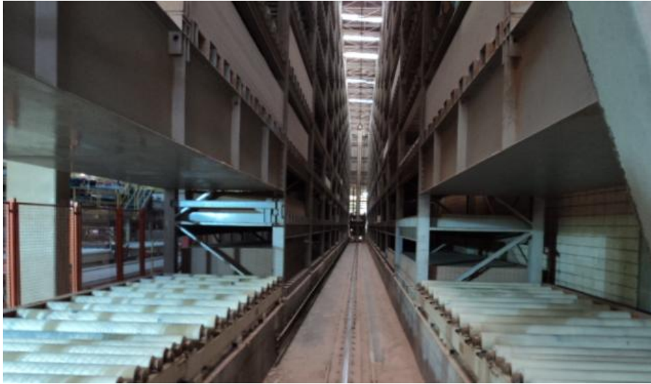
Figura 10- Estoque Vertical (ponto de climatização da chapa)
