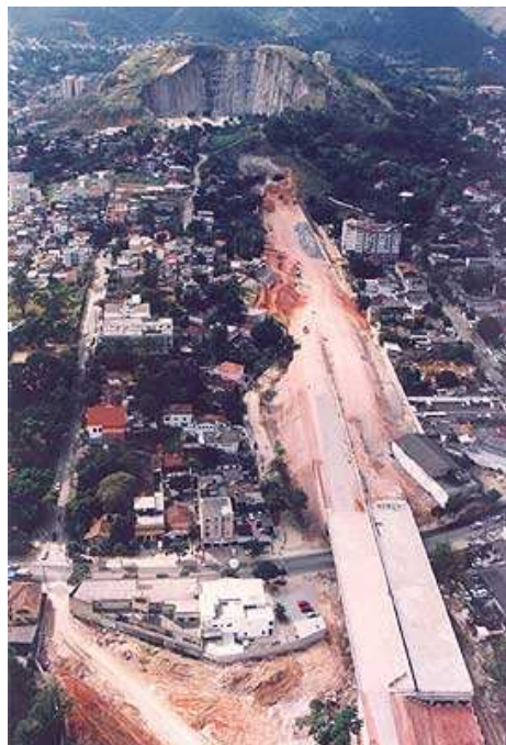
Figura 11. Construção de trecho da Linha Amarela, Rio de Janeiro. Fonte: LAMSA (2008).
