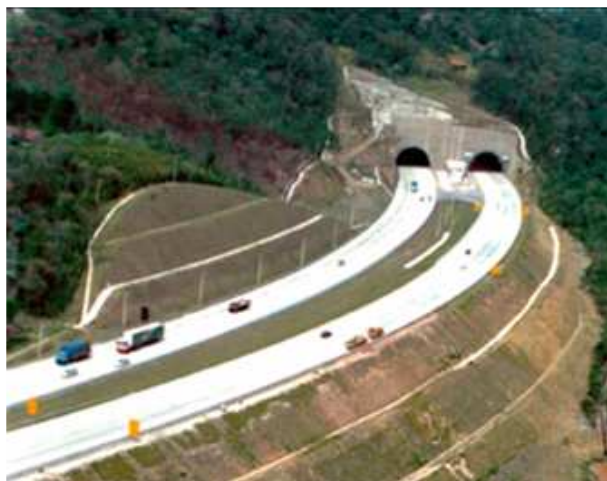
Figura 18. Rodoanel: Túnel 1 Emboque Gramado. Fonte: DERSA (2008)..
