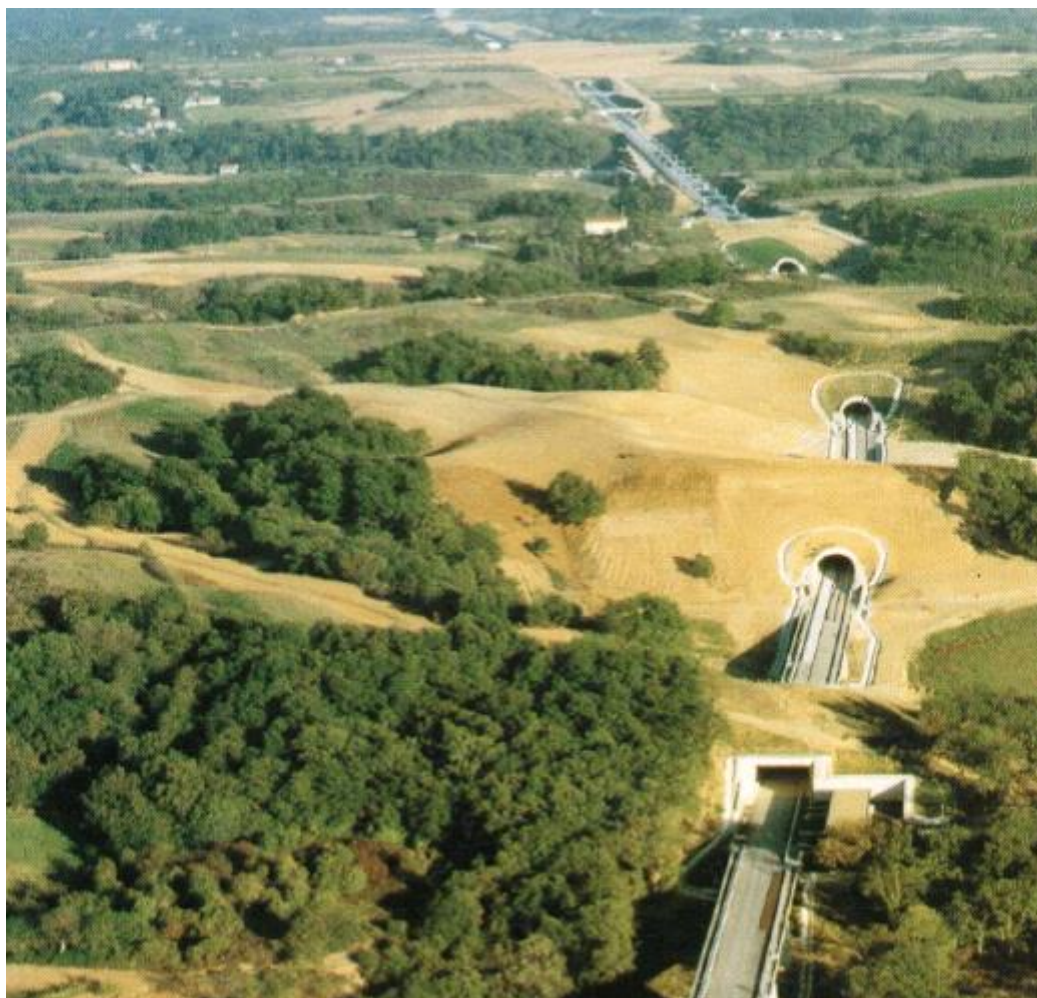
Figura 11. Foto ilustrativa de linha de trem de alta velocidade com túneis e pontes. Fonte: Agência de Desenvolvimento de Trens Rápidos Entre Municípios.
