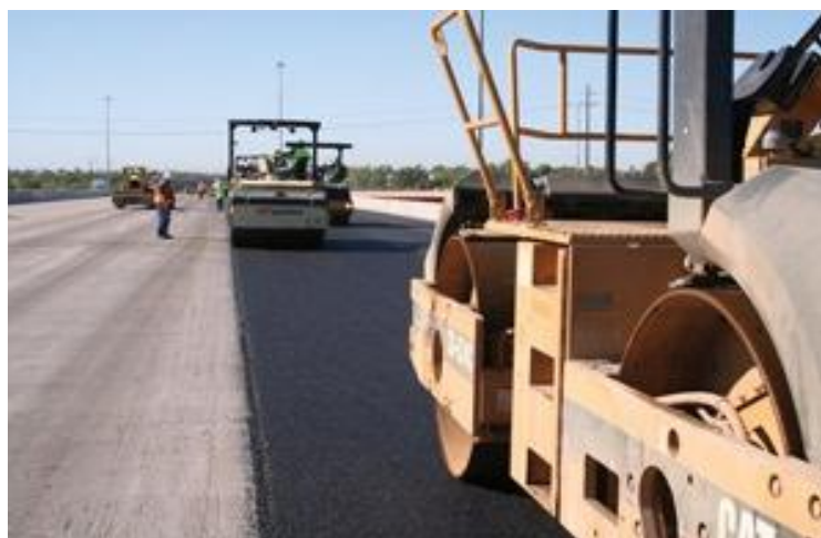
FIGURA 4. Borracha triturada na pavimentação de rodovias
