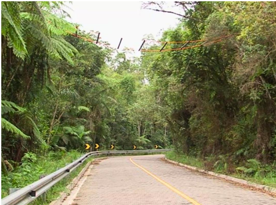
Figura 2 - Via SP-139 - Estrada Parque Carlos Botelho com acesso entre as árvores para os animais transitarem com segurança
