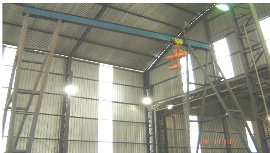
Figura 12 – Pórtico com talha manual existente
