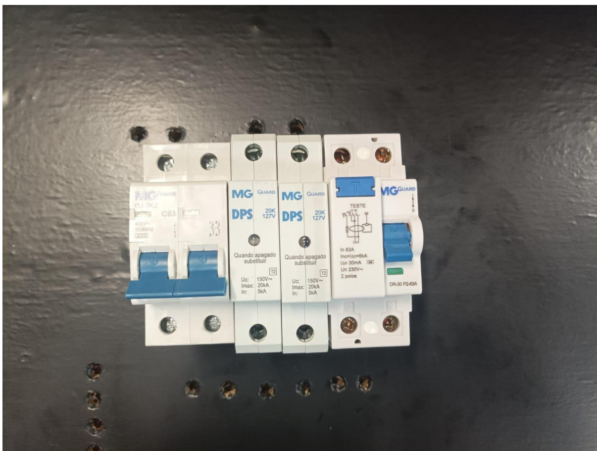
Figura 7 - Fixação dos Equipamentos de Proteção
