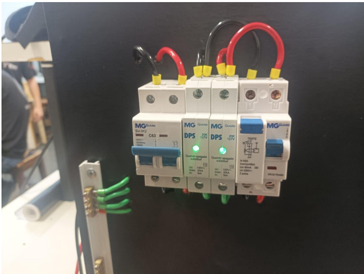
Figura 11 - Acionamento do DPS com aterramento
