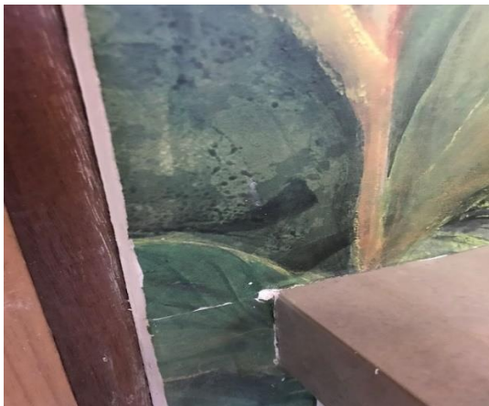
Rasgo nas folhas do papel de parede
