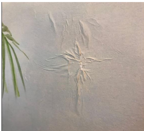
Bolhas de ar no papel de parede e rasgo
