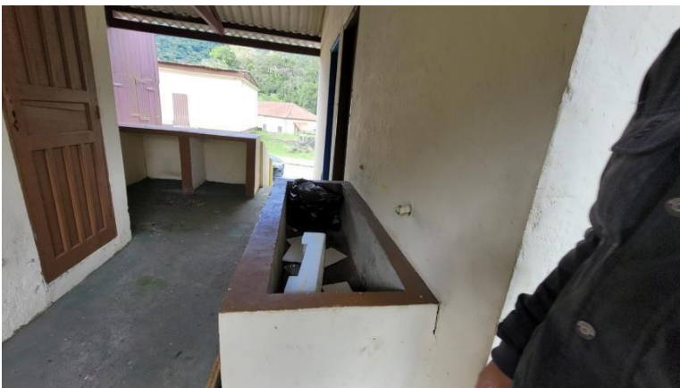
Figura 34 – Pia Externa da Cozinha
