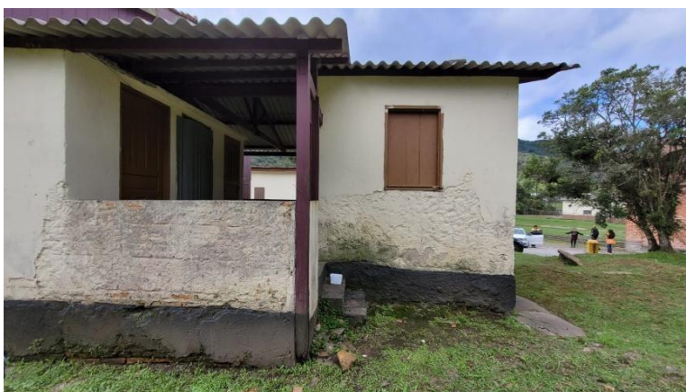
Figura 32 – Lateral do Anexo
