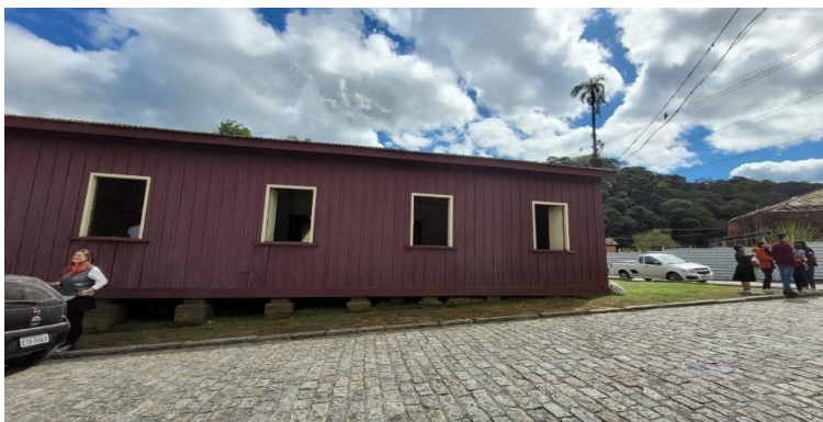
Figura 30 – Fachada Lateral Esquerda
