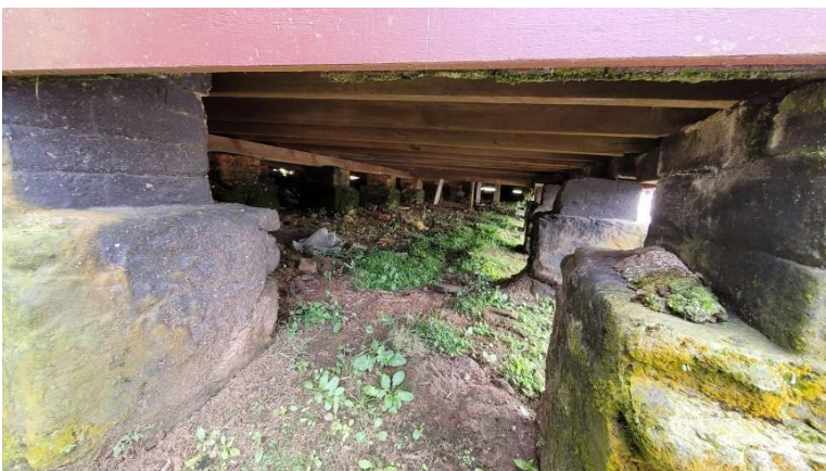
Figura 37 – Fundação do Imóvel
