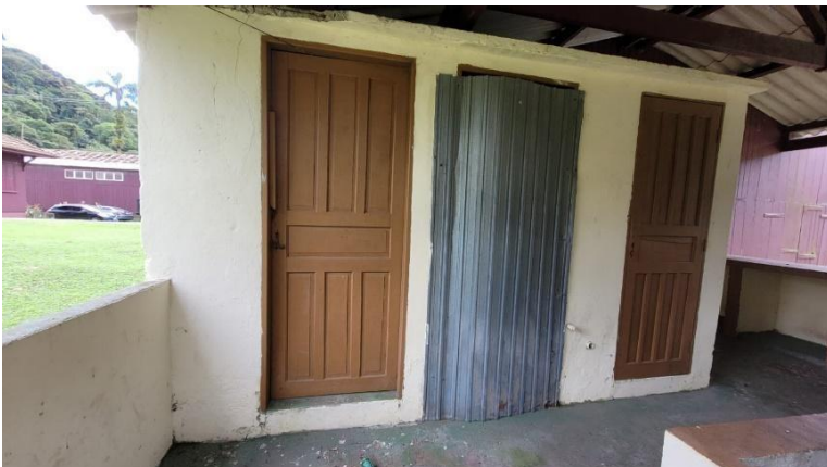
Figura 33 – Porta dos Banheiros
