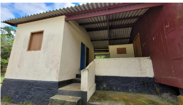
Figura 38 – Vista Lateral do Anexo
