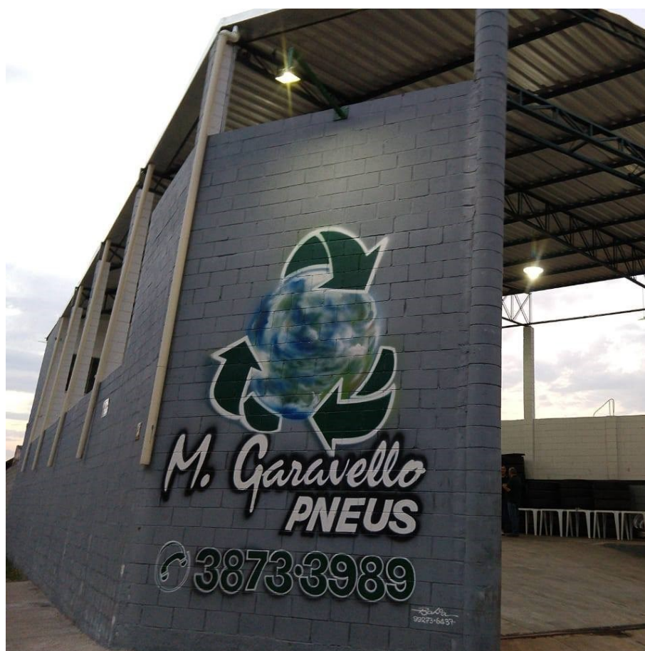
Figura 2 – Fachada da empresa M. Garavello Pneus Ltda.
