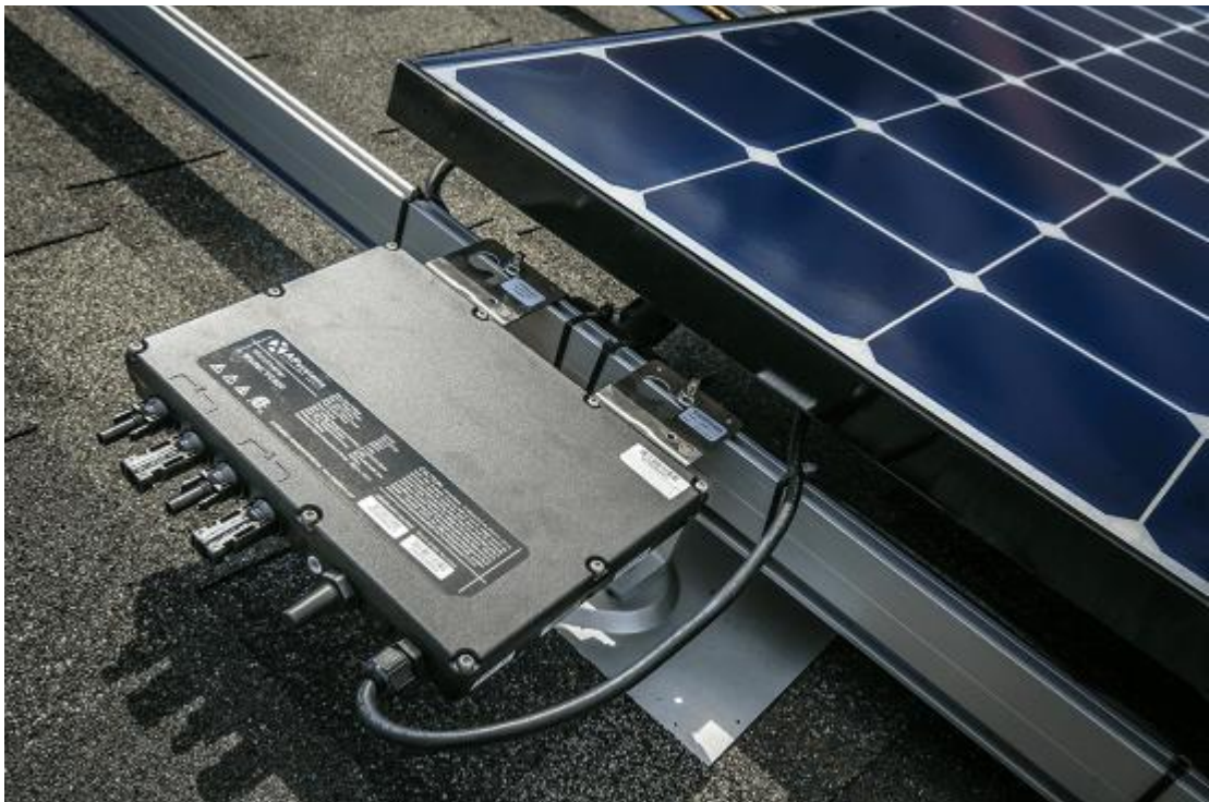
Figura 7.7. Microinversor solar já instalado no telhado
