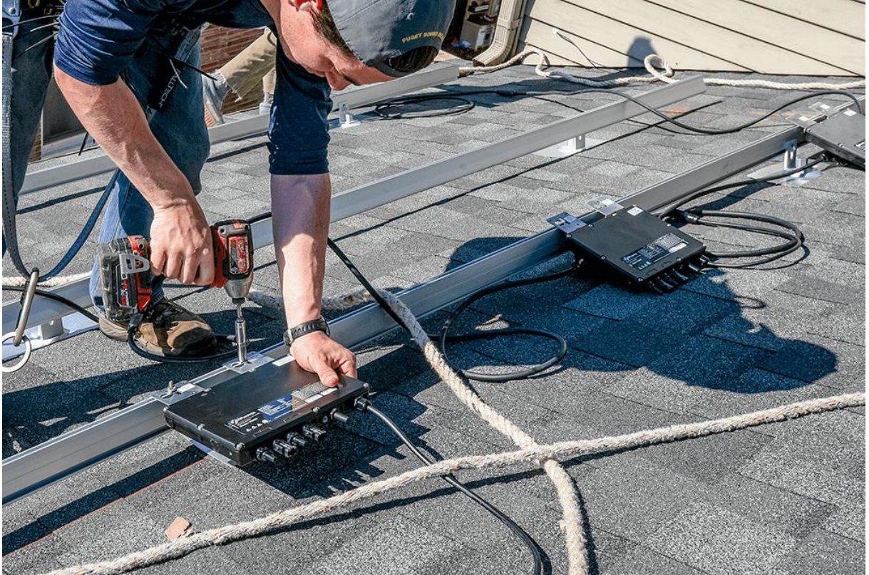
Figura 7.6. Instalação de Microinversor solar no telhado
