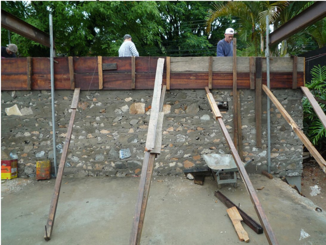
Imagem 4 – Concreto ciclópico em confecção.
