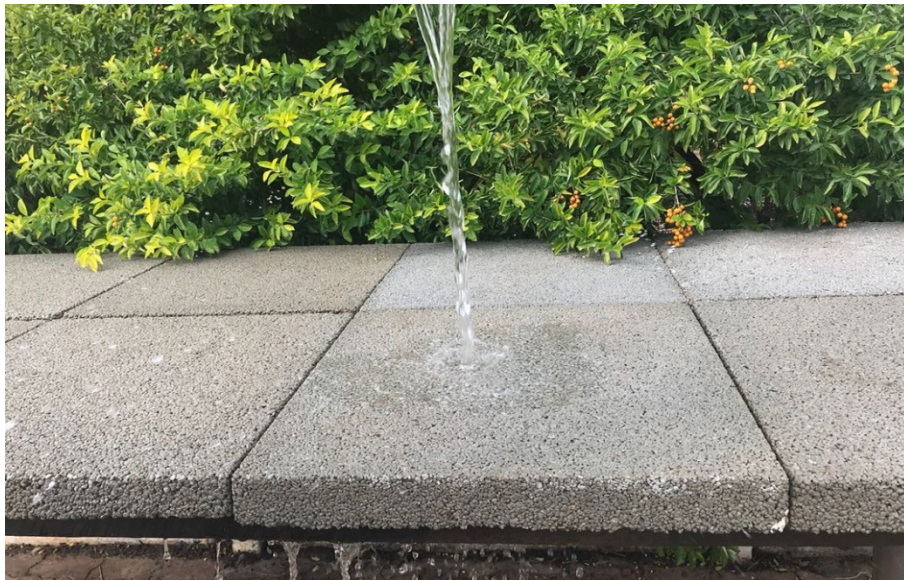
Imagem 2 – Piso drenante instalado.
