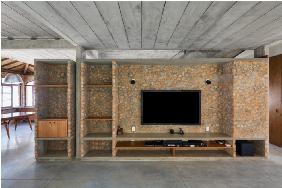
Imagem 3 – Concreto ciclópico confeccionado.
