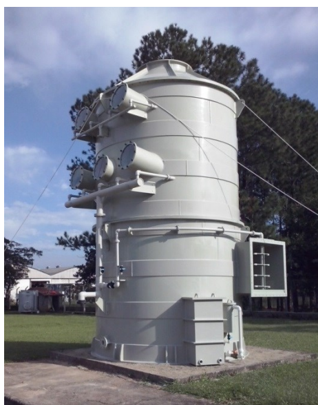
Figura 10: Lavador de gás remoção névoa de óleo.
