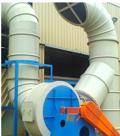
Figura 11: Sistema de ventilação.
