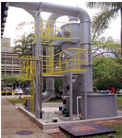
Figura 9: Lavador de gás tipo coluna de spray.
