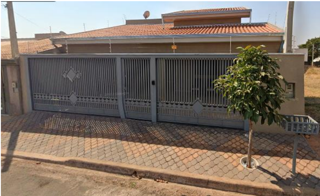
Figura 8 – Vista frontal do imóvel
