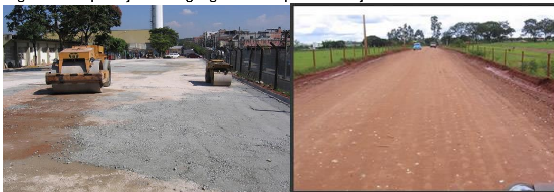
Figura 22: Aplicação de agregados em pavimentação e estradas.
