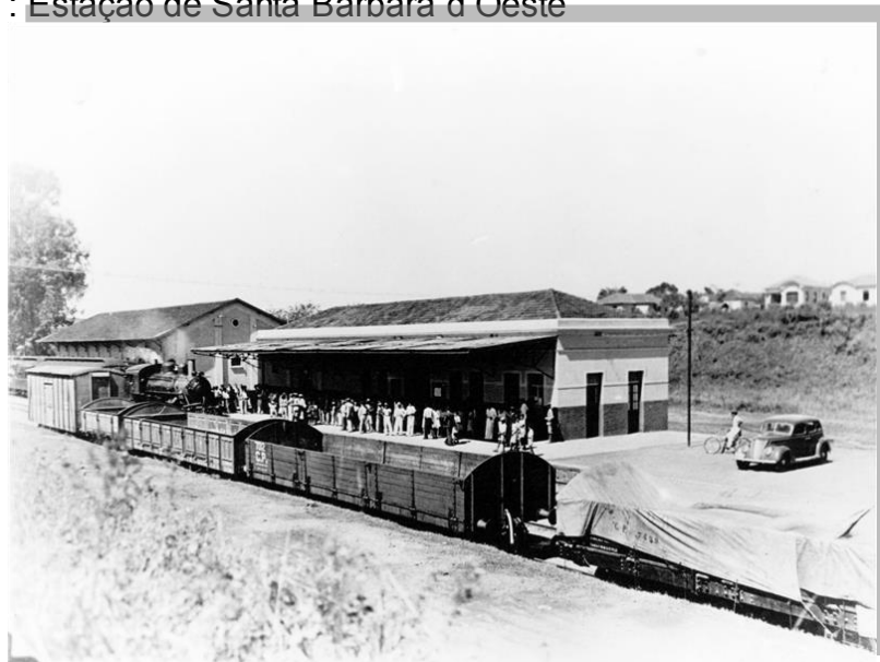
Figura 07 : Estação de Santa Bárbara d'Oeste
