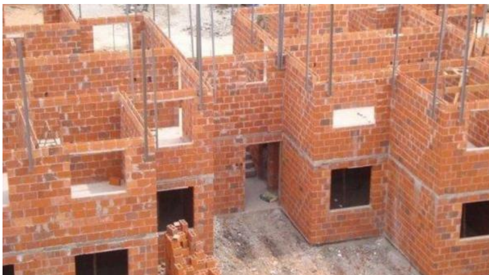
Figura 22: Estrutura de alvenaria convencional
