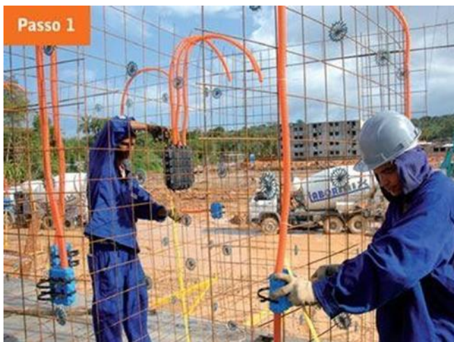
Figura 41: Passagem dos eletrodutos entre as telas de aço
