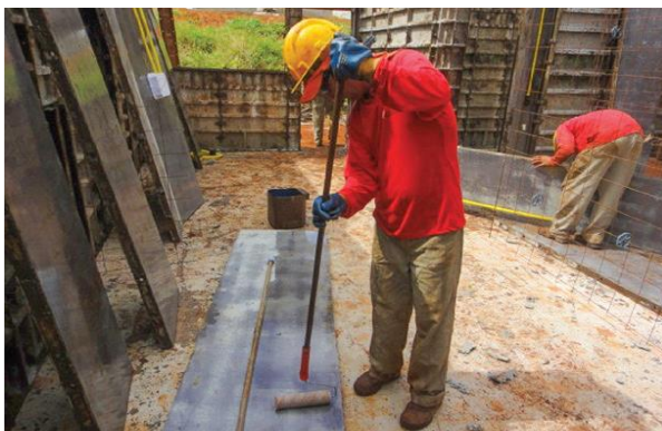
Figura 58: Aplicação do desmoldante
