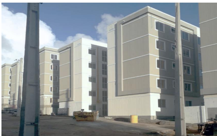
Figura 21: Vista lateral das unidades habitacionais
