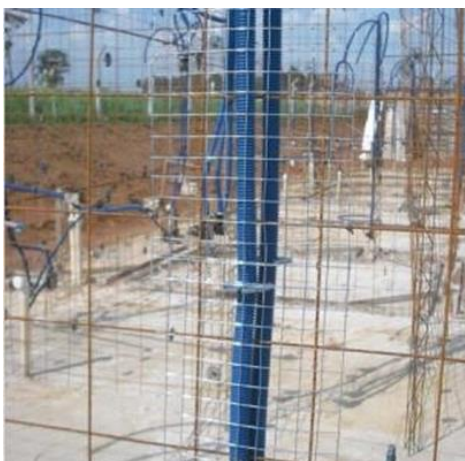
Figura 42: Tela armada em eletrodutos
