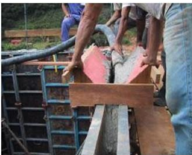
Figura 56: Lançamento de concretagem dentro dos vãos das formas
