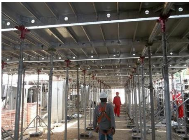
Figura 57: Escoramento de laje
