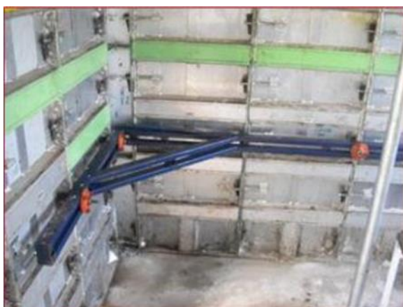
Figura 52: Esquadro de travamento
