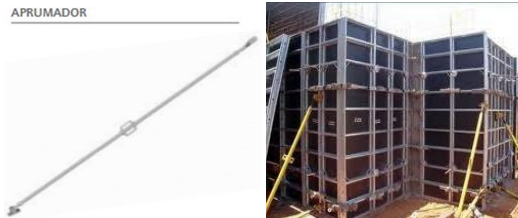
Figura 50 e 51: Aprumadores usados em formas de alumínio
