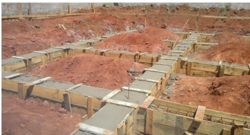
Figura 35: Fundação de viga baldrame
