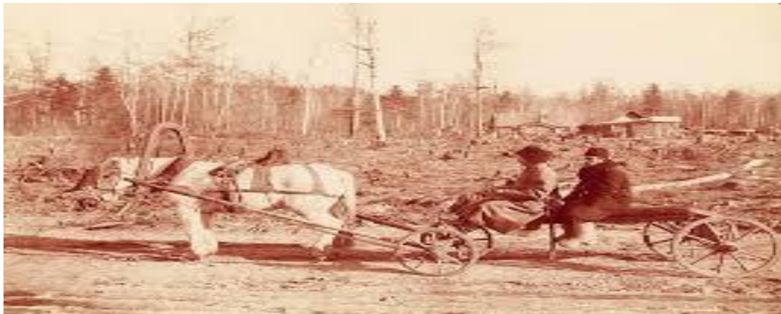
Figura 9 – Foto dos Veículos utilizados na Construção da ferrovia no Leste da Sibéria
