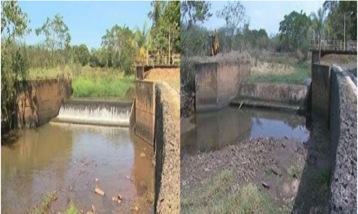
Figura 5: Foto da captação do Rio Canoas em período de chuva e de estiagem
