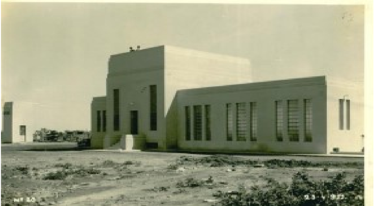
Figura 6: Início das obras da E.T.A da Sabesp Franca/SP
