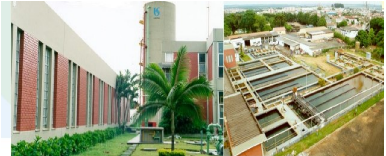
Figura 8: Sistema de Tratamento de água Norte da Sabesp Franca/SP
