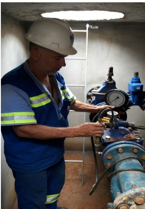
Figura 18: Calibração de VRP
